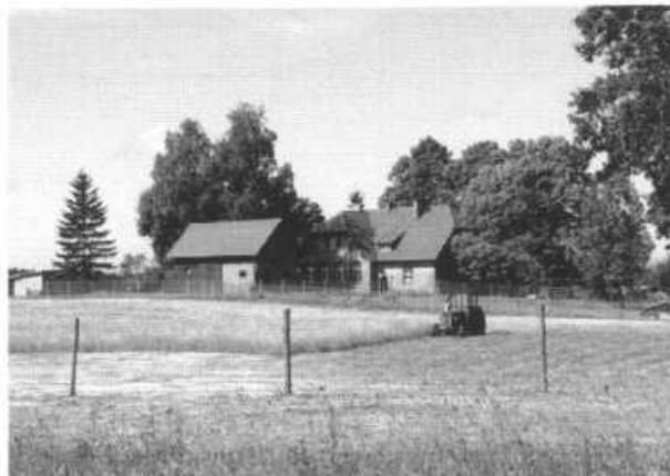
Wyremontowany dach na budynku poszkolny w Bartlu —efekt realizacji Pomorskiego Programu Odnowy Wsi w ubiegłym roku
