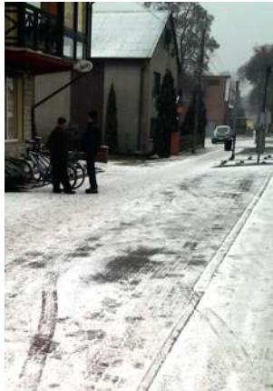
Remont parkingu ul.Długa, Kaliska
